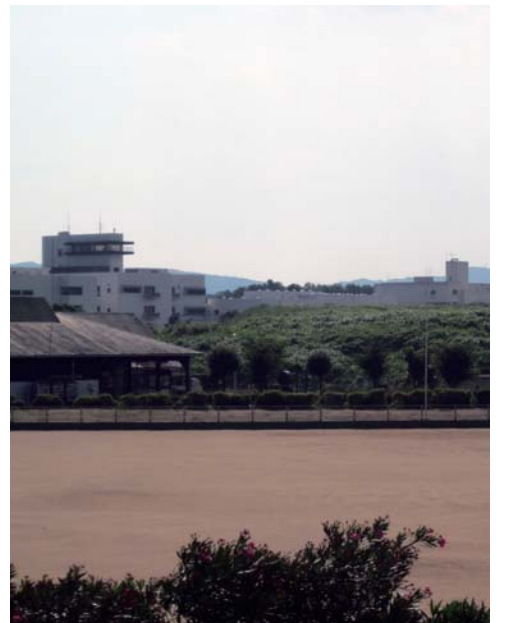
第二浄化センター
