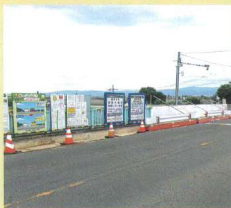
鳥居大橋の拡幅工事
